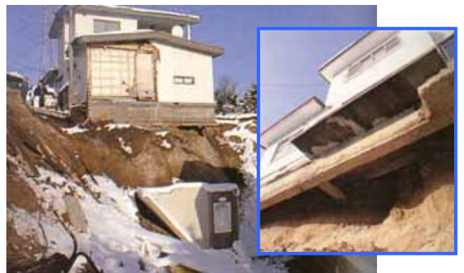
地すべりで倒壊した家屋
