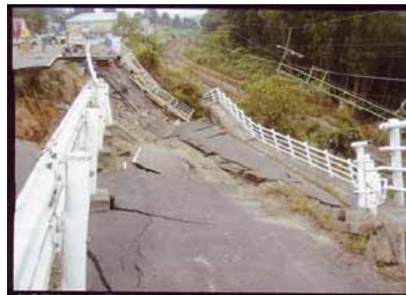
線路と平行している道路が線路と同様に崩壊（R17）
