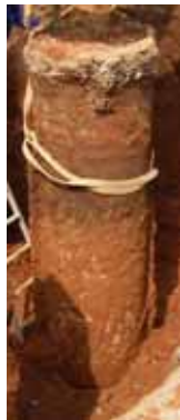
きっちり工事した場合の 実際の改良体側面の写真
